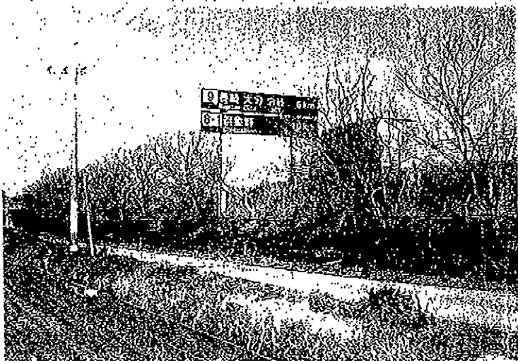
写4-3. 事例としての久留米市宮の陣付近鳥橋JCT近くの冬の状況。 植栽後約13年、2001.2.
