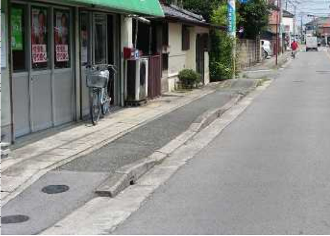
近くに大きな病院があり、小中学校の通学路でもある区間に残るマウントアップ形式の歩道
