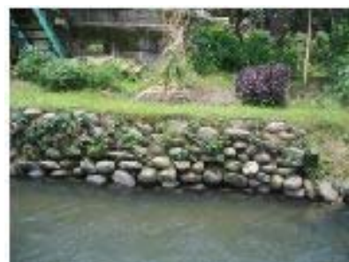
山内地区水路：所々に植物はあるが、基本的にはコンクリートで固められており植栽を行う必要がある。また、玉石積みされているところはコケが生えやすく産卵場所として使える。
