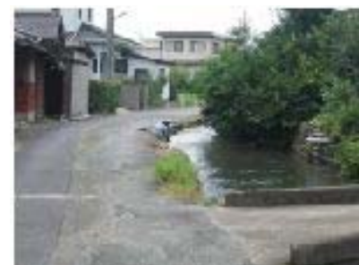
山内地区水路：所々に植物はあるが、基本的にはコンクリートで固められており植栽を行う必要がある。また、玉石積みされているところはコケが生えやすく産卵場所として使える。
