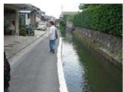
山内地区水路：所々に植物はあるが、基本的にはコンクリートで固められており植栽を行う必要がある。また、玉石積みされているところはコケが生えやすく産卵場所として使える。
