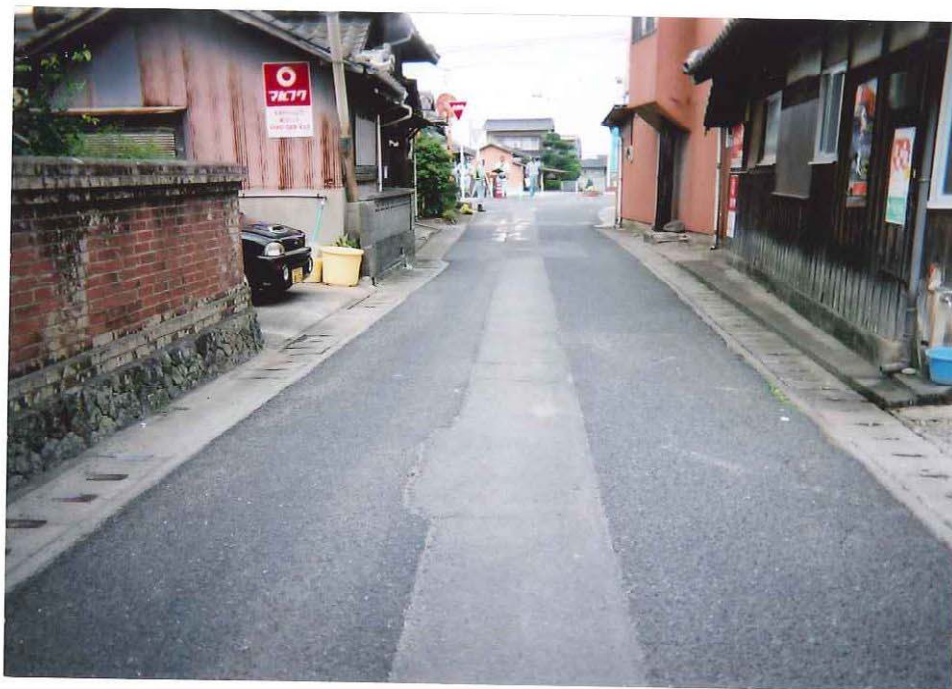
写真-2 中津市公共下水道事業における現地調査の様子
