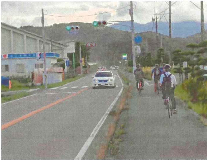
歩道は2mと狭い。自転車の通行が可能となっている。
