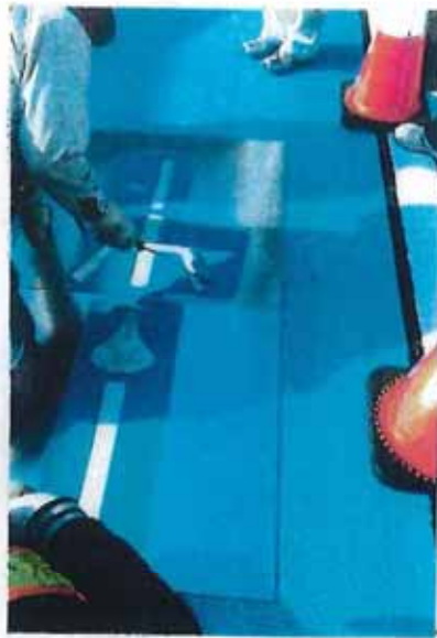
プライマー塗布
