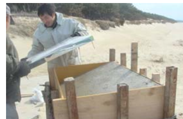
(写真-1) 台座に時計版取付け
