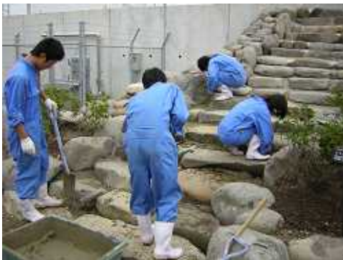
石工技術の伝承 自然石を利用した階段製作
