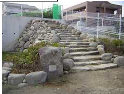
石工技術の伝承 自然石を利用した階段製作
