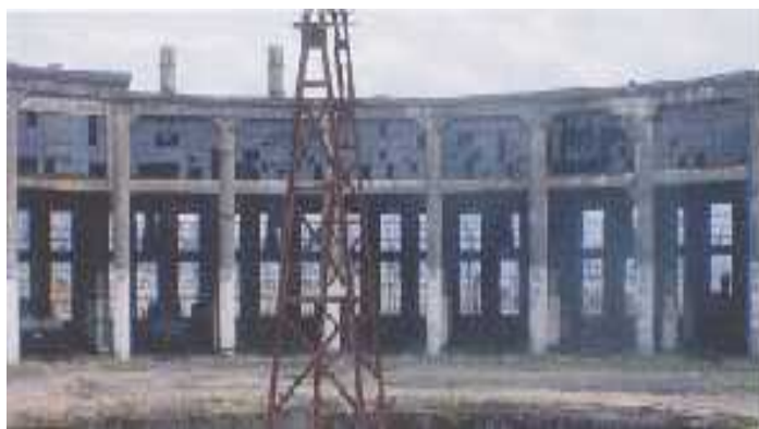
写真 1 現在の機関庫（筆者撮影）
