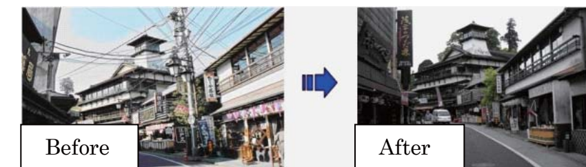
※成田市 電線類地中化事業 引用
