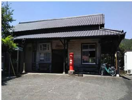
九州一古い木造駅舎 油須原駅
