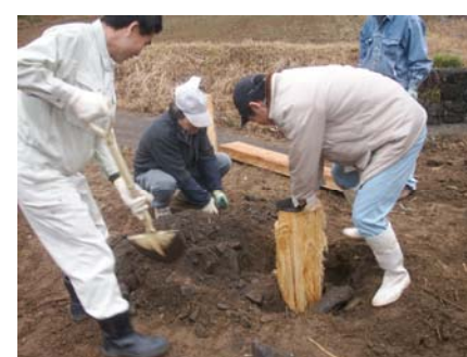
整地が終わり、ベンチの設置へ
