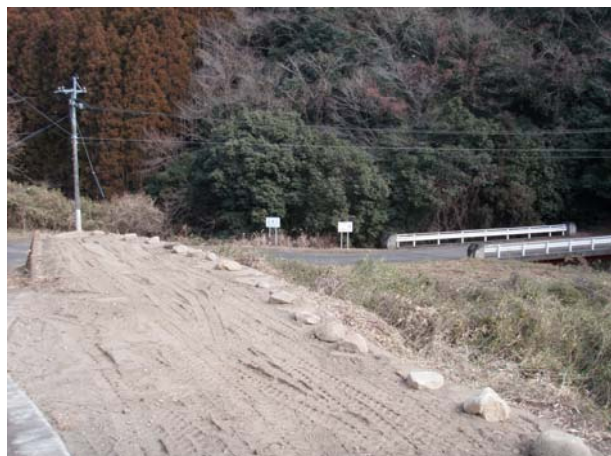
1/30 施工後の状況
