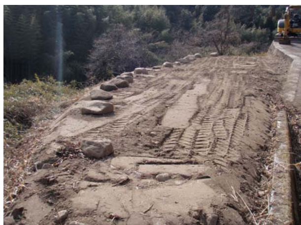
1/30 施工後の状況
