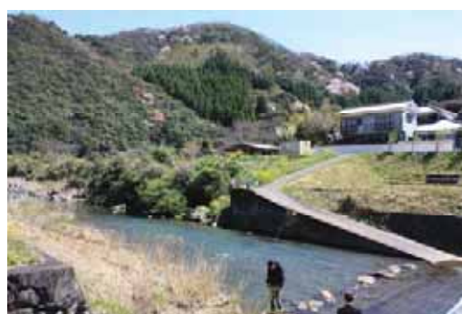
写真一四 新たに設置された飛び石
