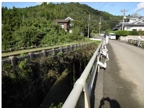
写真一10 樋ノ口橋（左、右は新橋）
