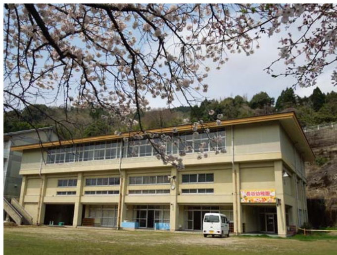
「ながたに推進協議会」の本拠施設（体育館1階部の旧長谷幼稚園）
